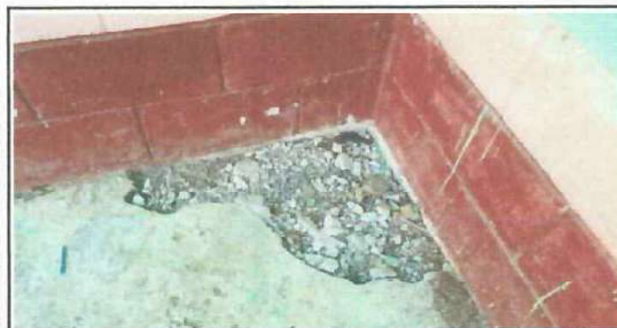
Foto 3: Se observa el desprendimiento de la torta del piso de el aula 10 del módulo No. 4.
